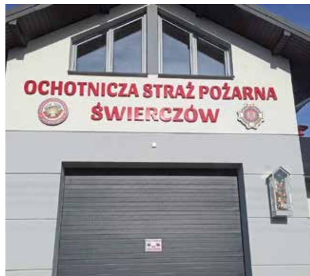
Fasada nowej remizy
