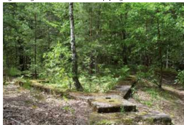
Pozostałe fundamenty po wieży.
