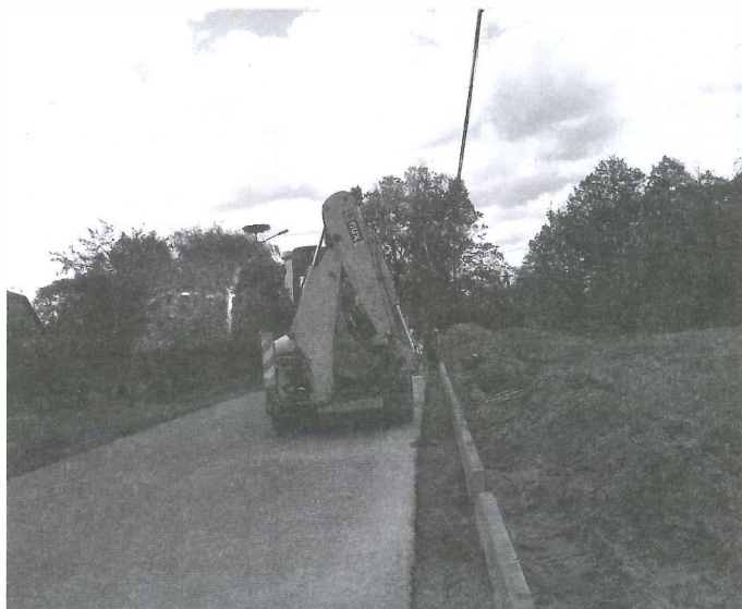
W trakcie budowy jest chodnik dla pieszych przy drodze powiatowej Nr 1213 Widelka-Hucisko.
