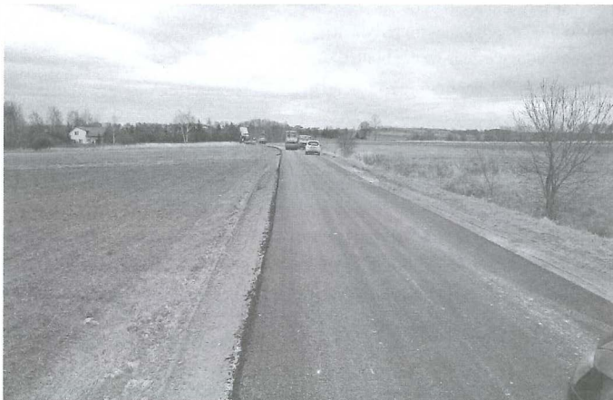
Rozbudowa drogi Kolbuszowa Górna- Wojków, fot. A. Selwa
