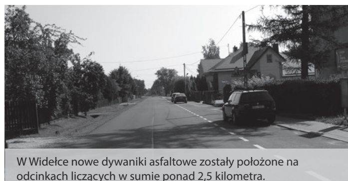
Odremontowana droga powiatowa w Widełce. Fot. B. Żarkowska
