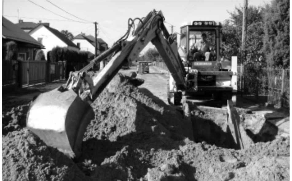
JUDYTA SNOPKOWSKA Prace budowlane potrwać do października przyszłego roku. Fot. J.Snopkowska.
