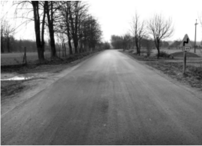
Wzmocniono istniejącą podbudowę i wykonano warstwę cierną na drodze powiatowej nr 1 207 R Raniów – Porby Wolskie, na długości 1 286 mb. Wartość inwestycji: 311,789 zł. Fot. A. Jarosz
