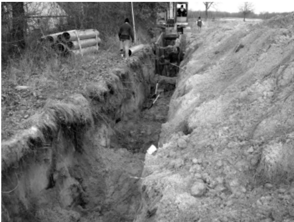
Prace przy budowie kanalizacji
