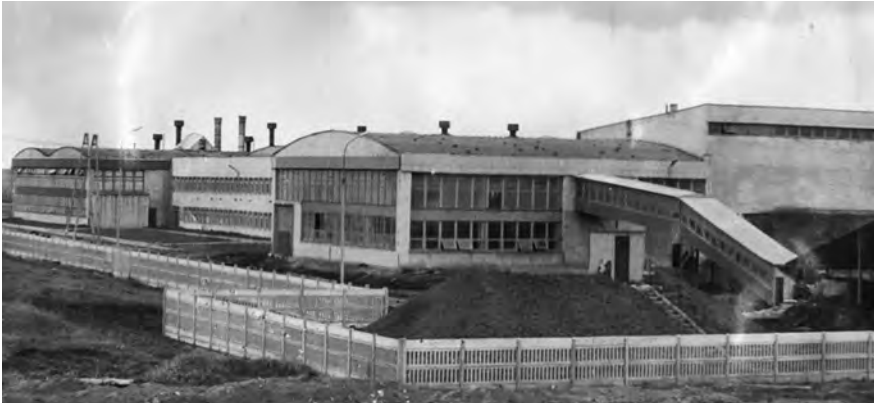
LATA 70. UBIEGŁEGO WIEKU. ZAKŁAD CERAMIKI W KUPIE, WIDOK OD STRONY POŁUDNIOWEJ
