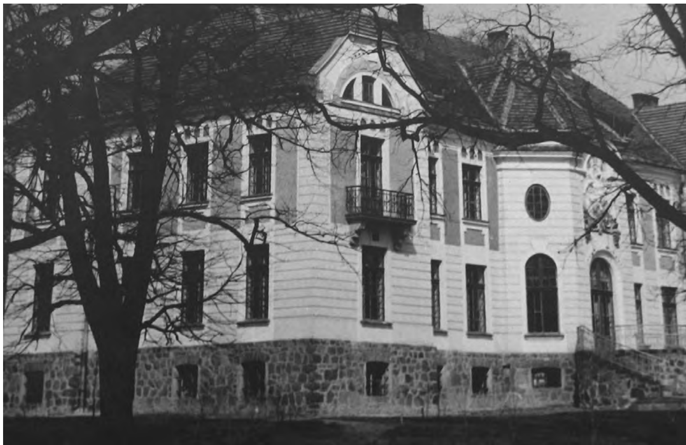
PAŁAC W WERYNI – REZYDENCJA TYSZKIEWICZÓW, WYKORZYSTYWANY JAKO BUDYNEK SZKOLNY I INTERNAT (ZDJĘCIE WYKONANE W LATACH 1963/1964 R. PRAWDOPODOBNIIE PRZEZ FRANCISZKA BATOREGO – PRZYPIIS AUTORA).
