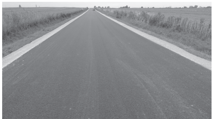
Nowy dywanik asfaltowy na drodze powiatowej w Woli Raniżowskiej. Fot. B. Żarkowska
