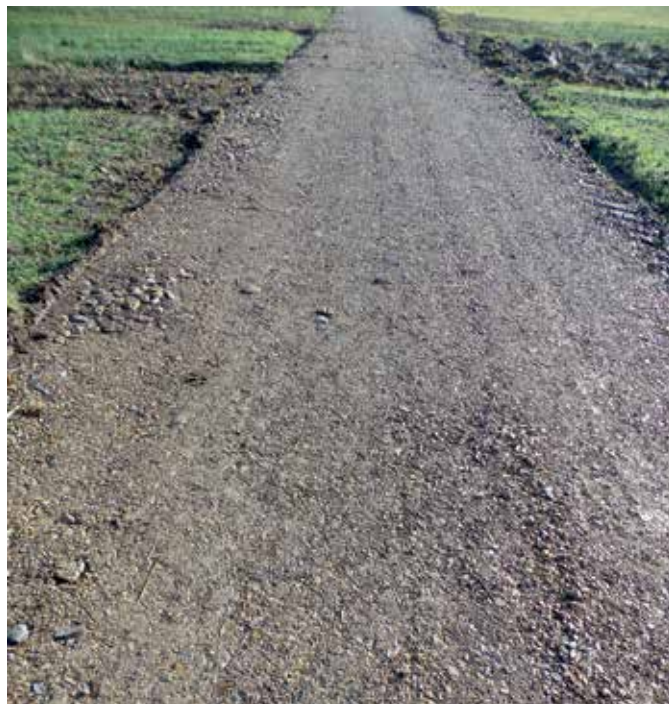
Zmodernizowana droga śródpolna w Woli Raniżowskiej...
