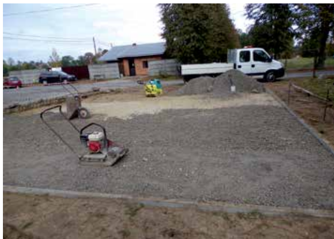
Pracy budowlane przy utwardzaniu placu obok remizy w Korczowiskach
