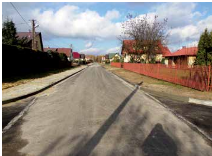
... i po przebudowie
