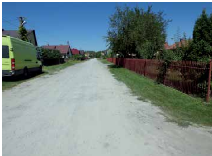
Ulica Ks. Gołdasza przed przebudowa ...
