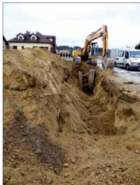
Prace budowlane przy zastosowaniu płyt wykopowych w rejonie ulicy Kasztanowej w Raniżowie...
