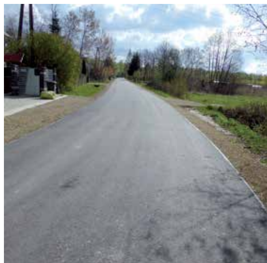
Droga gminna relacji Staniszewskie – Zielonka została przebudowana z udziałem środków finansowych PROW
