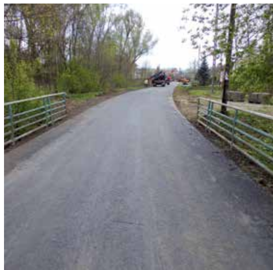
Ostatnie prace przy przebudowie drogi gminnej na ul. Lisy w Ranizowie
