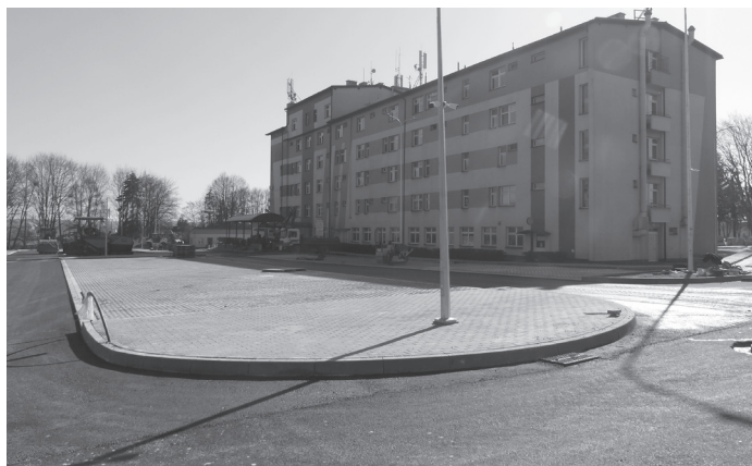
Słoneczna aura sprzyjała wykonywaniu prac budowlanych
