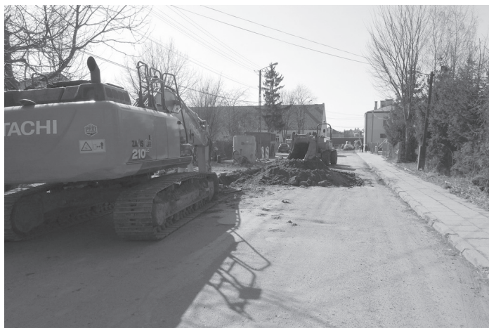
Roboty budowlane na ul. Kolejowej
