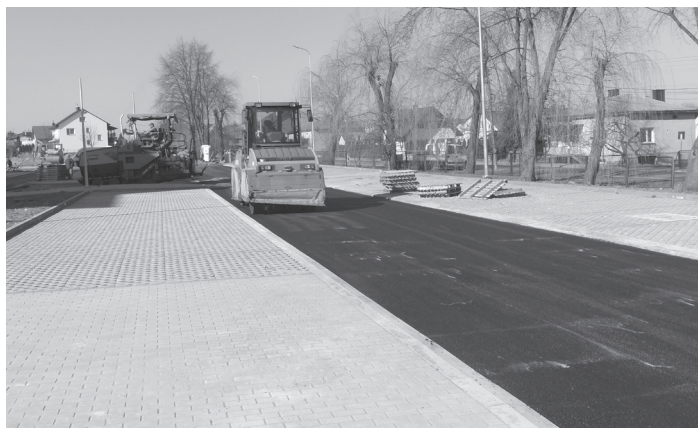
Prace przy Szpitalu Powiatowym w Kolbuszowej. Fot. B. Żarkowska
