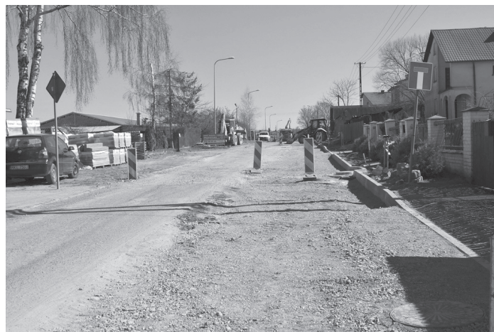
Roboty prowadzone na ul. Wiktora
