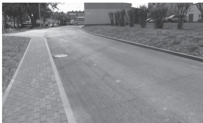
Prace przy Szpitalu Powiatowym w Kolbuszowej
