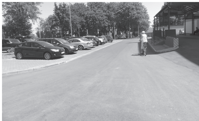
Przebudowane zostały również drogi dojazdowe oraz trakty wewnętrzne
