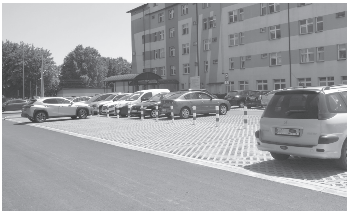
Inwestycja obejmowała przebudowę szpitalnych parkingów
