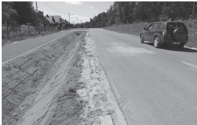
Prace remontowe trwają
