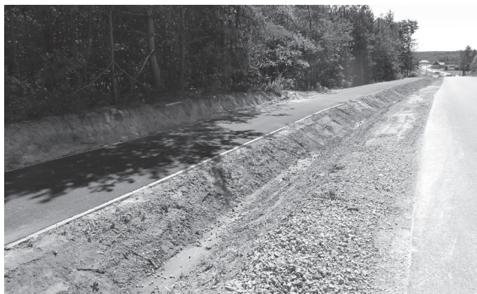
W ramach tego zadania remontowana jest droga oraz budowany jest ciąg pieszo-rowerowy
