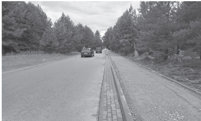
Prace przy budowie chodnika w Wilczej Woli
