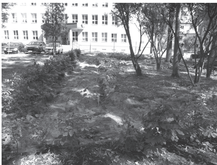
Prace modernizacyjne w Weryni
