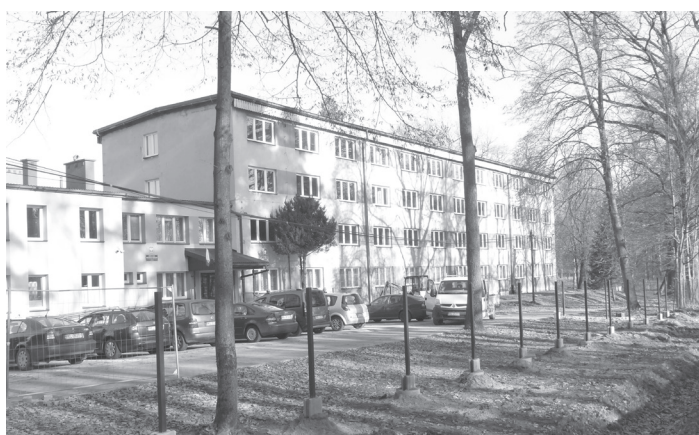
Budowa ogrodzenia w Zespole Szkół Agrotechniczno-Ekonomicznych w Weryni
