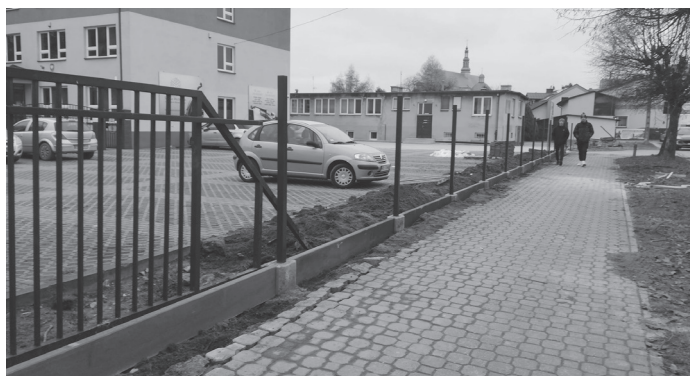
Wymiana ogrodzenia przy Zespole Szkół Technicznych w Kolbuszowej
