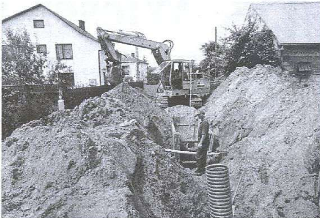
Budowa kanalizacji na osiedlu Skotnia w Raniżowie
