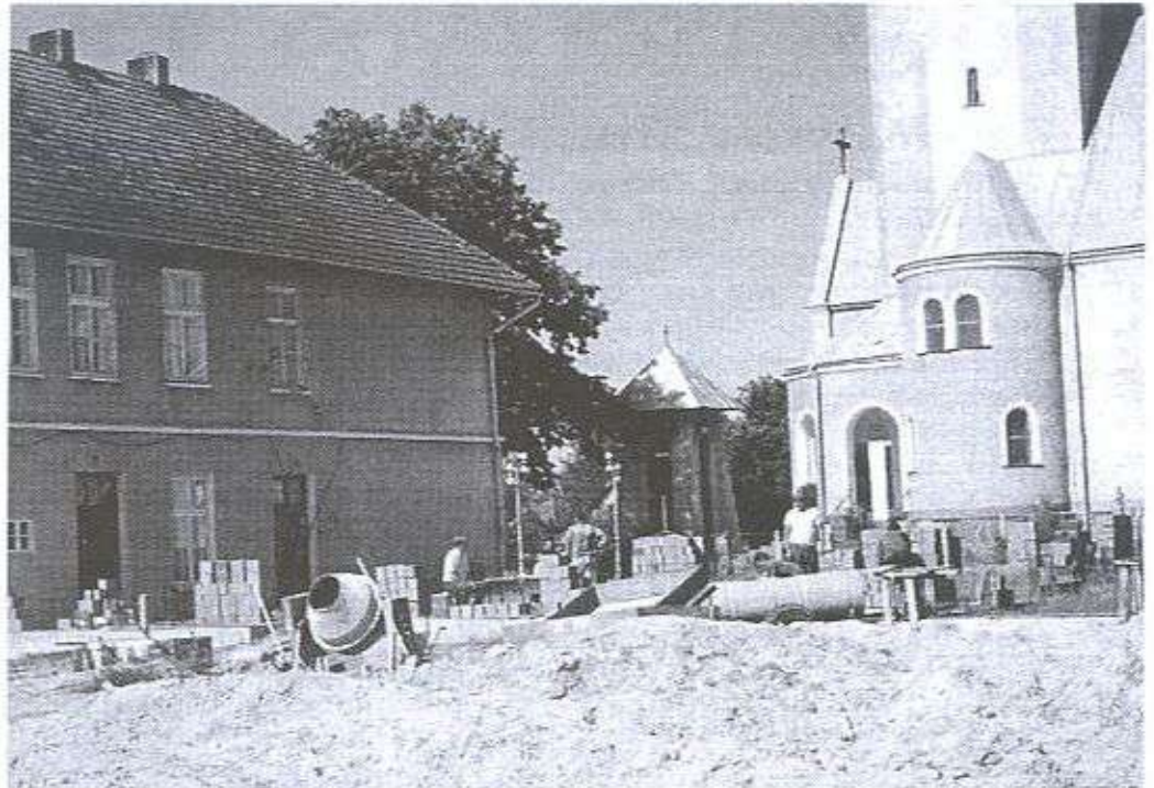
Rozpoczęcie rozbudowy szkoły w Mazurach w dniu 31.07.1999r.
