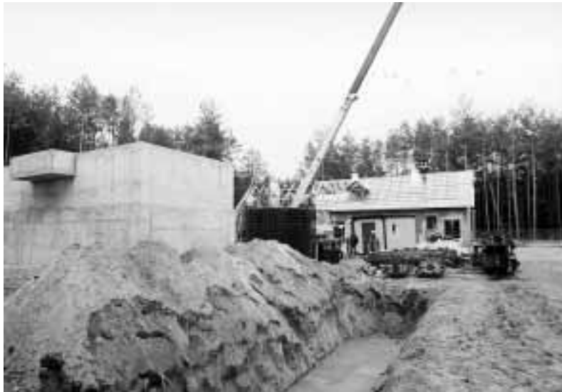
Plac budowy gminnej oczyszczalni ścieków w dniu 3.11.1999r.
