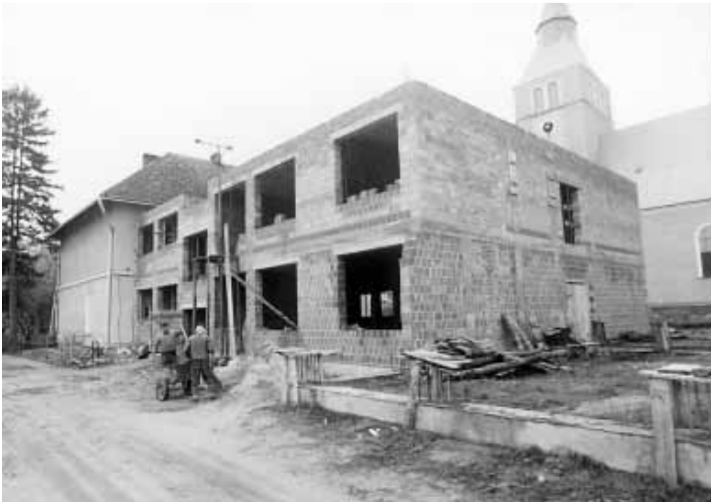
Plac budowy Szkoły Podstawowej w Mazurach.
