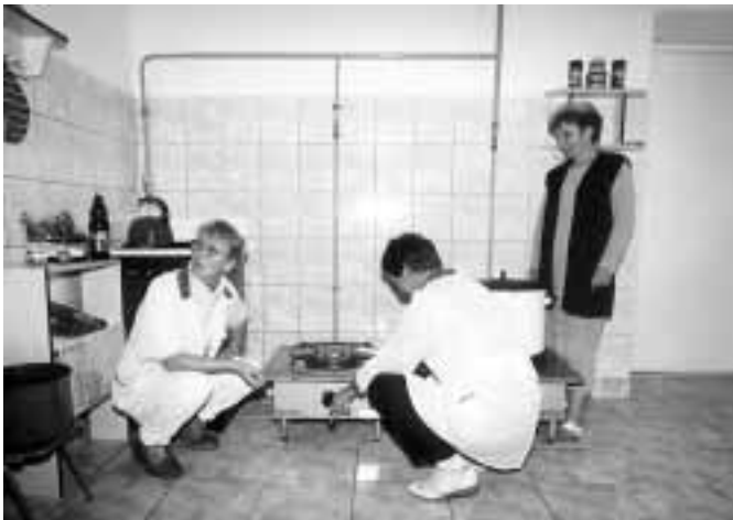
Odpalenie płomienia gazowego przez p. Annę Mazgaj w wyremontowanej kuchni Przedszkola w Raniżowie. Z lewej: p. Danuta Kubas, z prawej: dyr. Maria Pruś.
