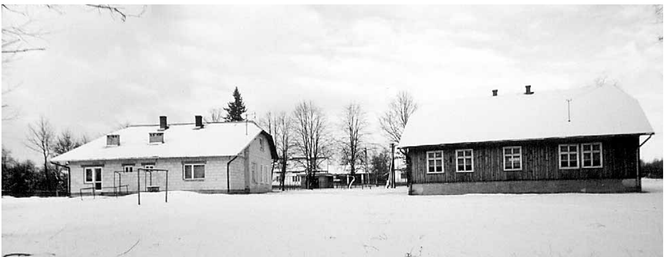
Widok budynków szkolnych: z lewej: starszy murowany budynek z dobudowaną częścią socjalną, z prawej: nowszy drewniany budynek szkolny.
