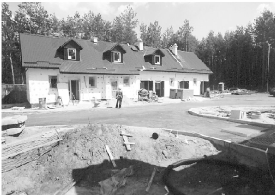
Plac budowy oczyszczalni i widok na budynek techniczno - biurowy.
