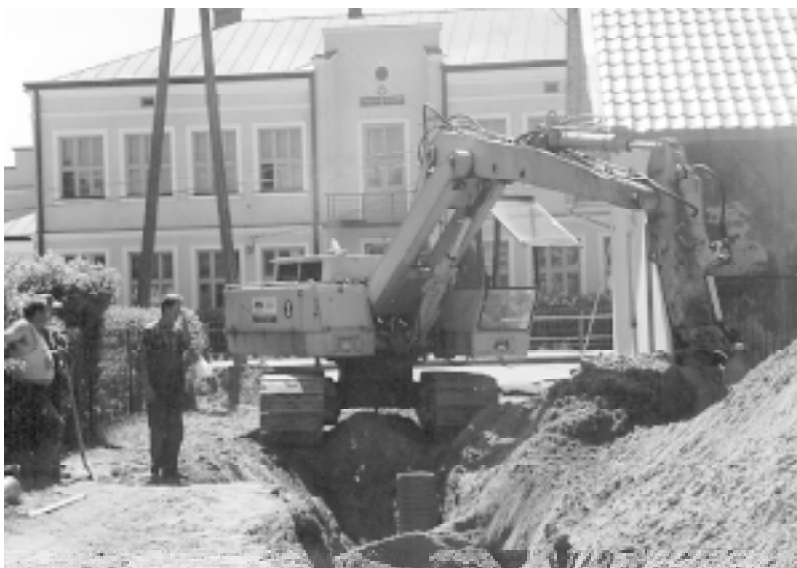
Budowa kanalizacji sanitarnej w centrum Raniżowa.
