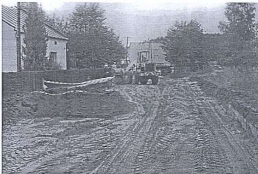
Rozpoczęła się modernizacja drogi dojazdowej do stadionu (7.08.2000r.).
