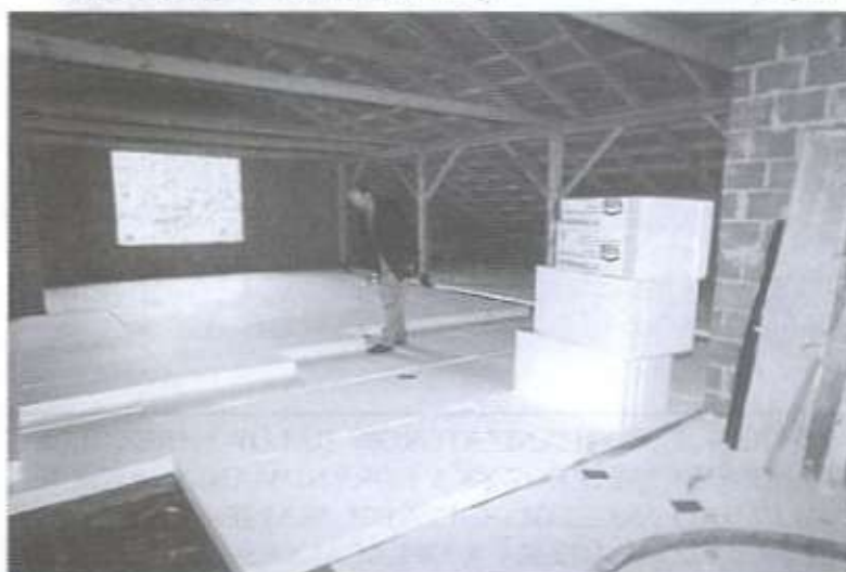
Trwają prace przy rozbudowie Szkoły Podstawowej w Mazurach. Na zdjęciu: Dyrektor Marek Wiącek ogląda ocieplenie strychu szkoły.
