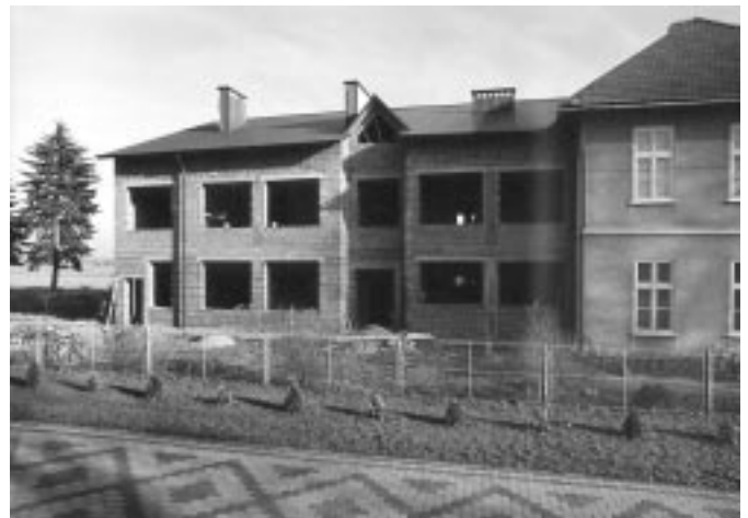
Trwa rozbudowa Szkoły Podstawowej w Mazurach (zdjęcie wykonano w listopadzie), obecnie jest zamontowana stolarka okienna i ocieplenie.
