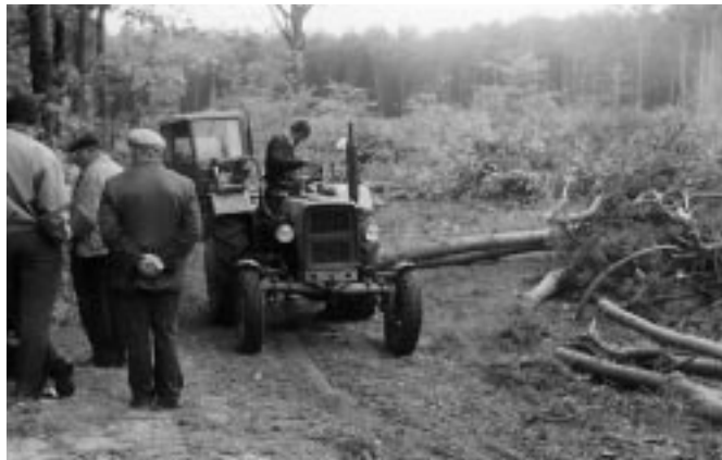
Październik 2000. Zrywka i wywóz drewna na placu budowy.
