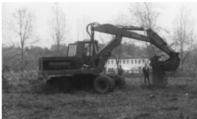
Październik 2000. Usuwanie pniaków i czyszczenie placu budowy.
