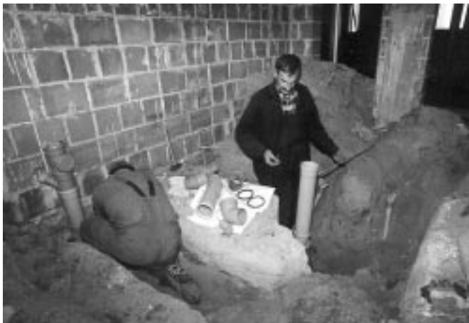
Prace instalacyjne w dobudowanej części Szkoły Podstawowej w Mazurach.
