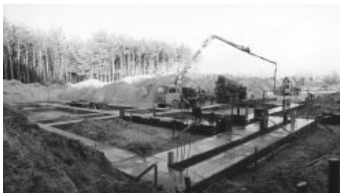
Grudzień 2000. Zalewanie betonem fundamentów.
