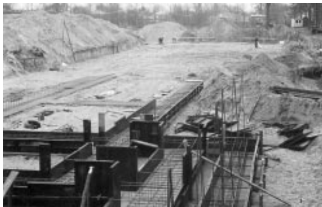
Grudzień 2000. Wykonanie wykopów i zbrojenie ław fundamentowych.
