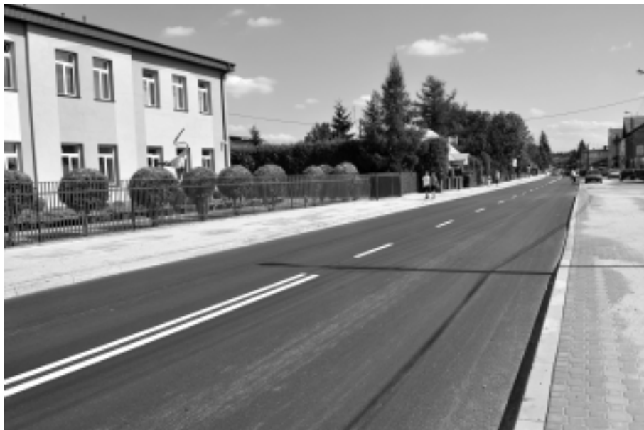
Wyremontowana nawierzchnia ulicy Obrońców Pokoju
