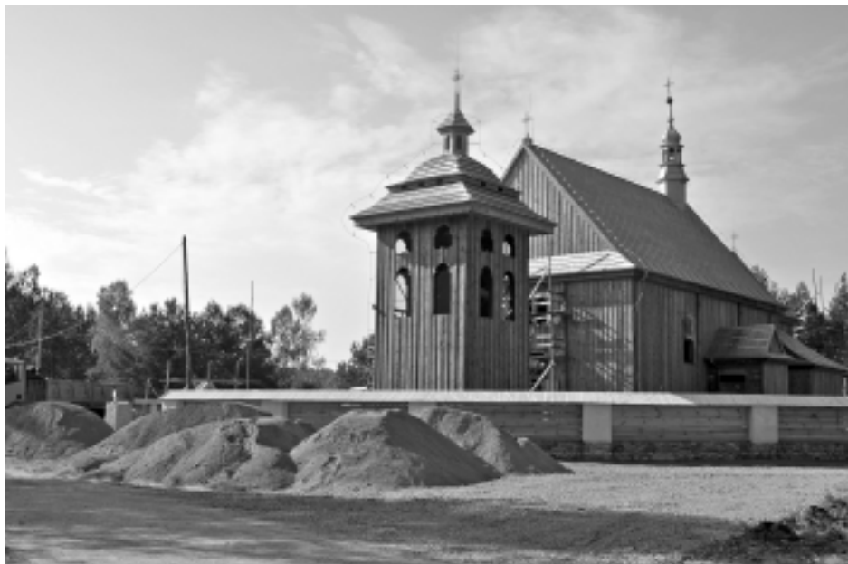
Kościół z Rzochowa - ostatnie prace, fot. J. Mazurkiewicz
