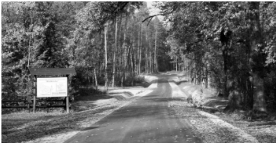
Asfaltowa droga pożarowa w leśnictwie Nowa Wieś
