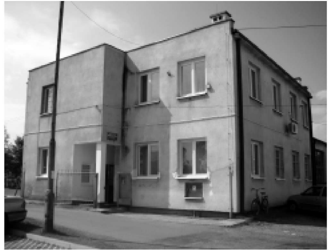
Już niebawem na placu przy MGOPS pojawią się ekipy remontowe. (fot. A. Kiwak)
