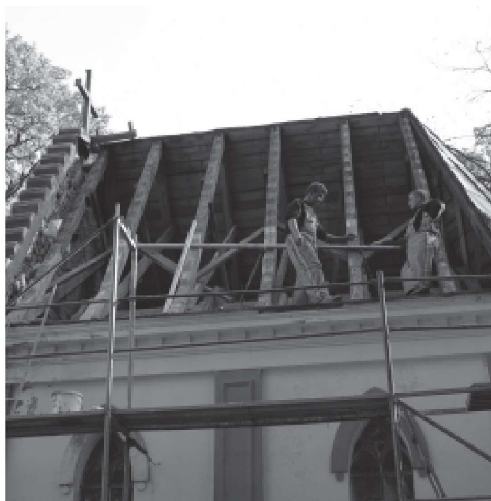
Rozpoczął się pierwszy etap remontu zabytkowej kaplicy z 1873 roku. Fot. W. Cesarz
