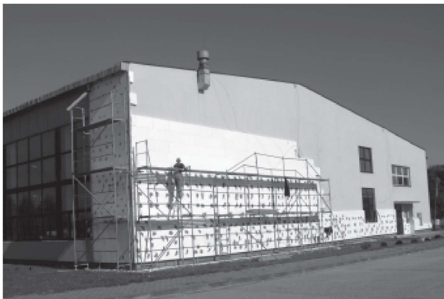
W Liceum Ogólnokształcącym w Kolbuszowej na ukończeniu są prace nad termomodernizacją całego budynku łącznie z halą widowiskowo-sportową. Fot. A. Jarosz
