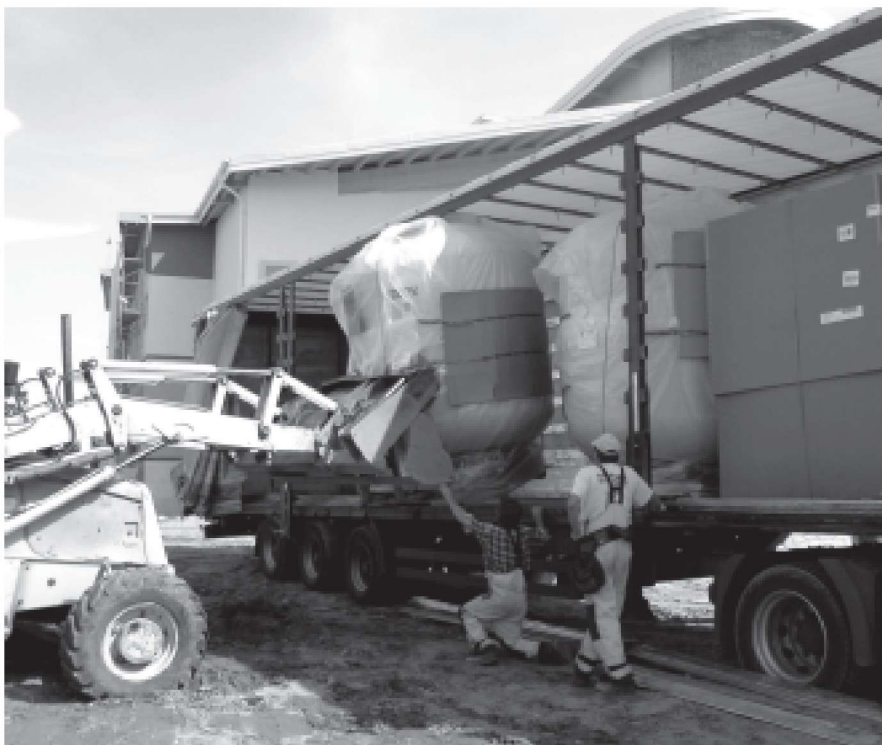
W budynku pływalni zainstalowano już 6 filtrów – 5 z nich ma średnicę 1800 mm – będą służyć do uzdatniania wody. Autor foto: (Jakub Knotz)
