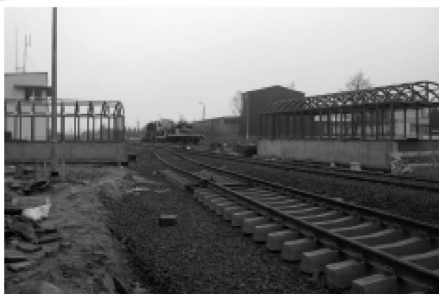
Trwają prace nad budową przejścia podziemnego. Fot. A. Jarosz
