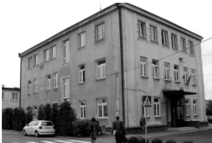
Dzięki unijnym środkom zostanie również wyremontowana elewacja budynku Urzędu Miejskiego w Kolbuszowej.
