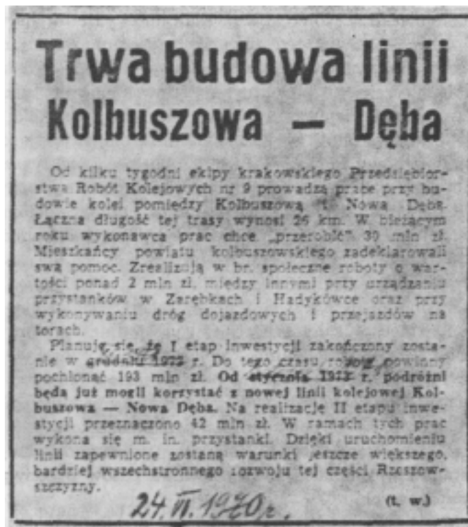
18. Fotografia wycinka z prasy o budowie linii kolejowej Rzeszów — Kolbuszowa — Dęba.
