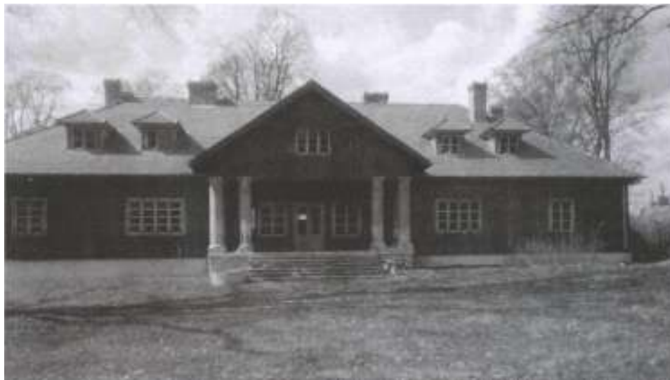
Dwór - leśniczówka w Wilczej Woli (elewacja frontowa - południowo- wschodnia).
