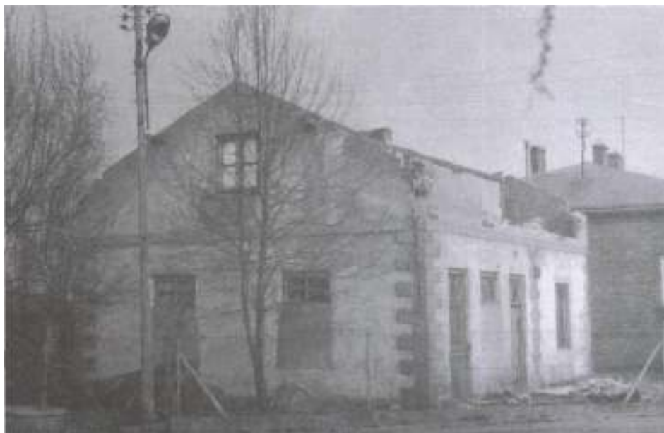
Budynek kałalnej rzeźni drobiu podczas rozbiórki w 1978r., w którym mieszkał dziadek z babcią. W tle nowy dom, w którym obecnie mieszkamy.
