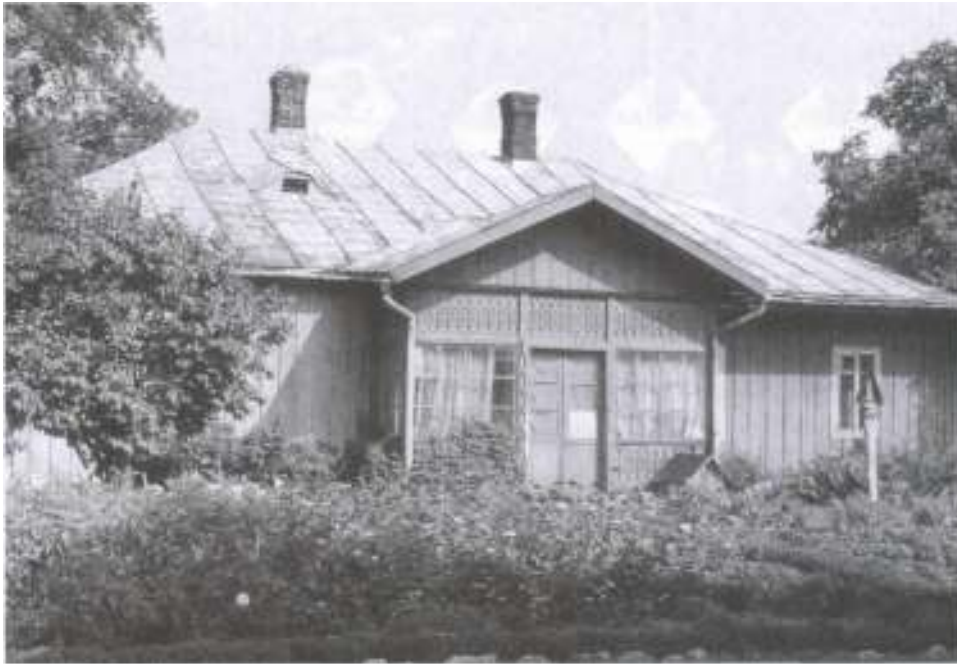
Stary budynek Sióstr z architektury dworu Tyszkiewiczów.
