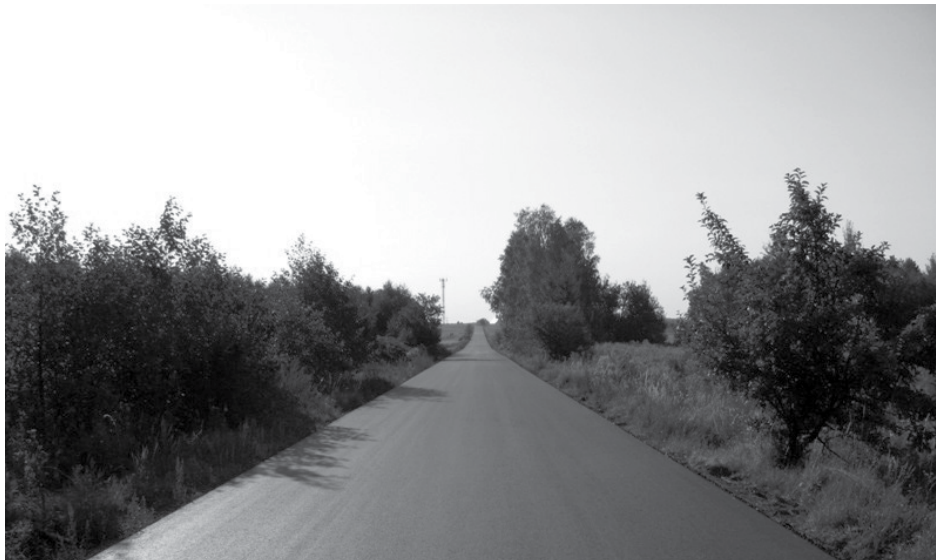
W trakcie jest remont drogi powiatowej Nr 1 204 R Majdan Królewski - Kopcie - Lipnica - Raniżów - Głogów Małopolski. W ramach remontu wykonano już nawierzchnię asfaltową na długości 9,7 km.
