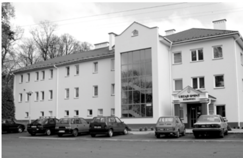
3 listopada oddano do użytku odnowiony budynek Urzędu Gminy w Dzikowcu.
