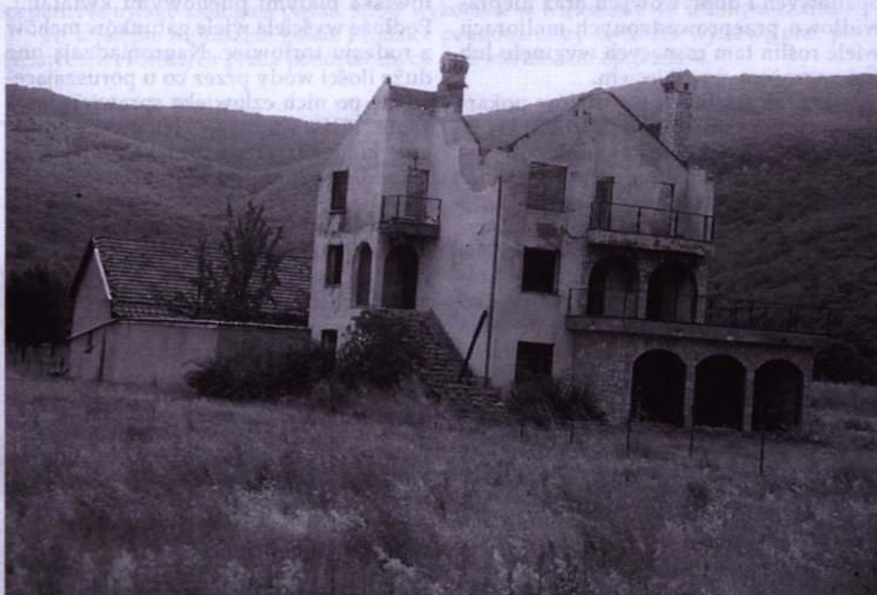
● Na murach zniszczonych budynków często widać ślady ostrzału z broni maszynowej - opuszczony dom w pobliżu granicy z Bośnią i Hercegowiną.
