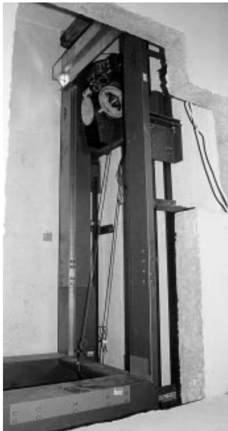
W nowym budynku Starostwa zamontowano już napęd windy osobowej...
