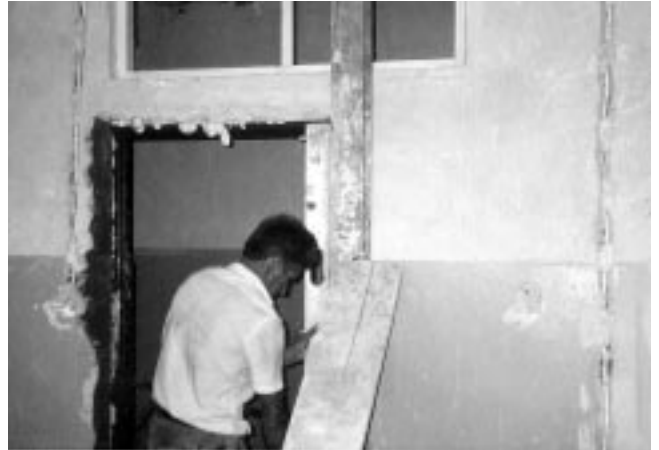
Trwają prace remontowe w przyszłych pomieszczeniach Inkubatora
