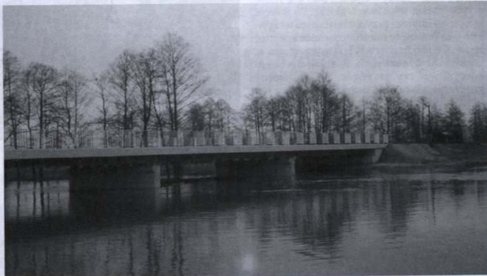
• Nowy most nie boi się wysokiej wody.
