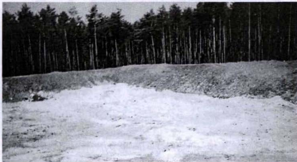
Odpady już zneutralizowane i przykryte warstwą piasku.
