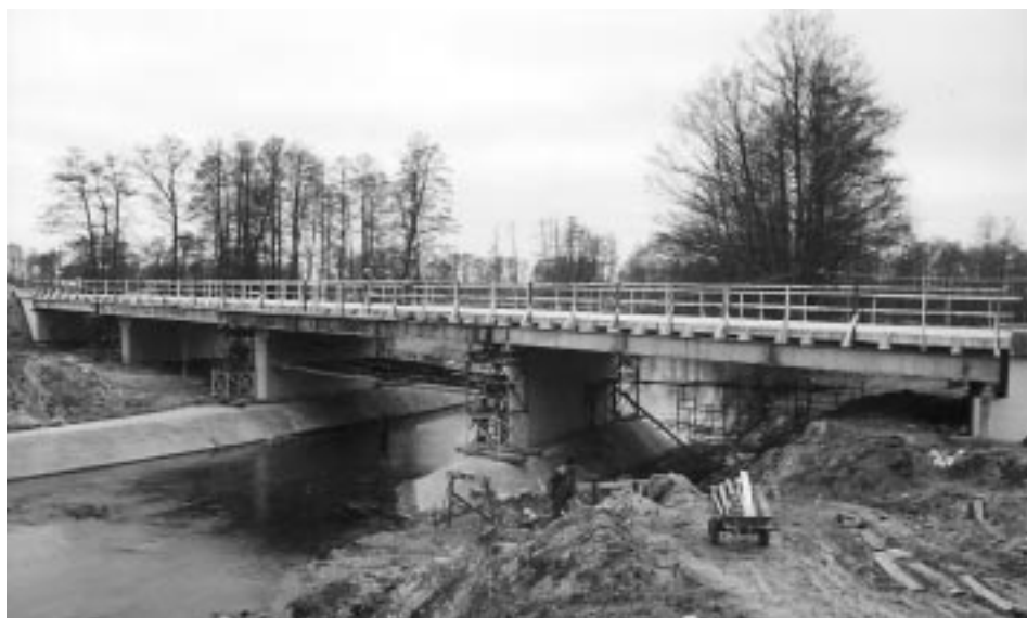
W przyszłym roku most na rzece Łęg w Spiach zostanie ukończony.
