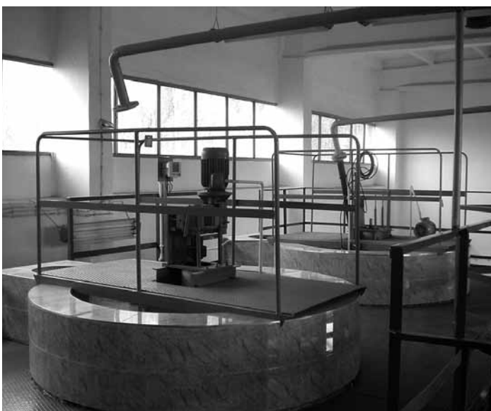
Hala stacji uzdatniania wody. Fot. Archiwum
