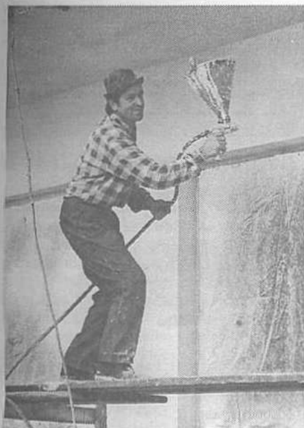
Elewacje wykonywane mechanicznie
