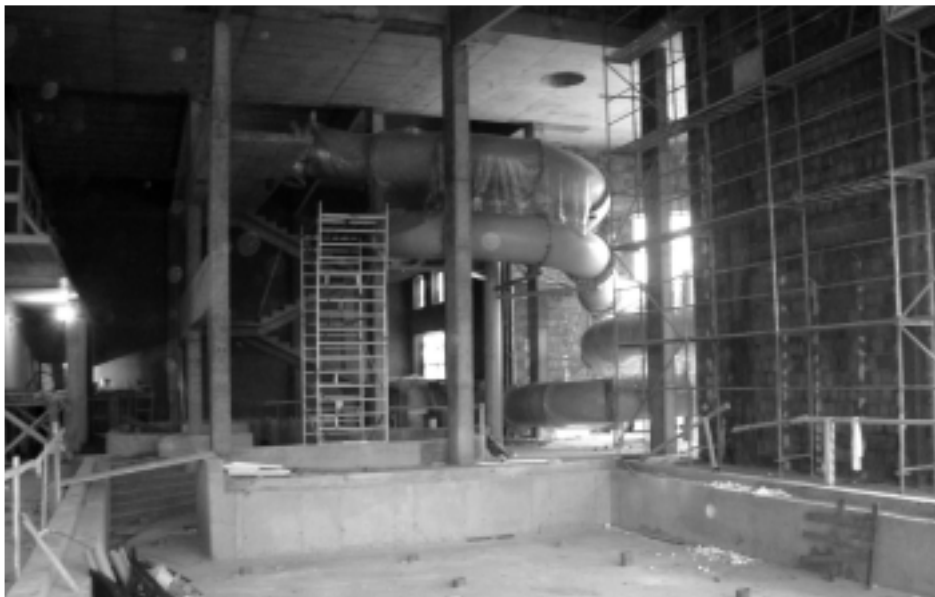
Montowane są kolejne elementy wyposażenia
