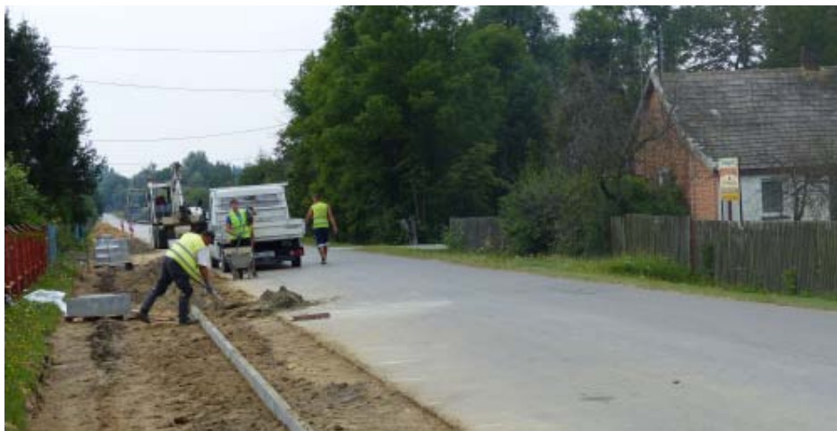
Prace przy budowie chodnika w Dzikowcu, przy drodze powiatowej Jagodnik – Cmolos – Mechowiec – Dzikowiec, już się rozpoczęły. Fot. B. Żarkowska
