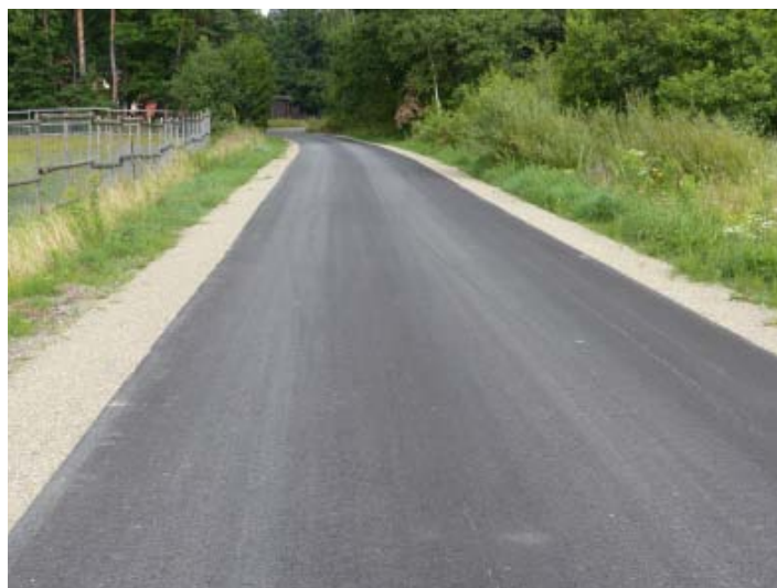
Odremontowany odcinek drogi powiatowej w Porębach Wolskich.
