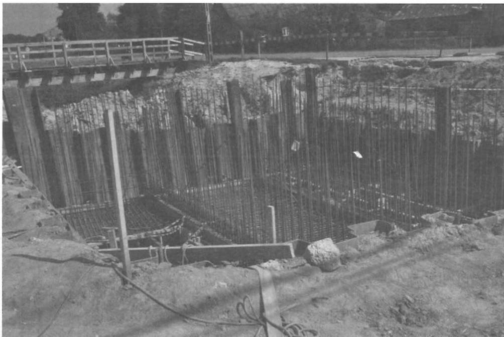
Trwa przebudowa mostu w ciągu drogi powiatowej w Widelce.
