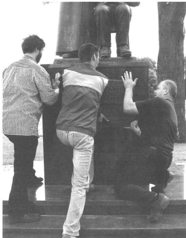
Ostatnia praca przy pomniku Twórców Parafii Mazury – mocowanie tablicy pamiątkowej na cokole.
