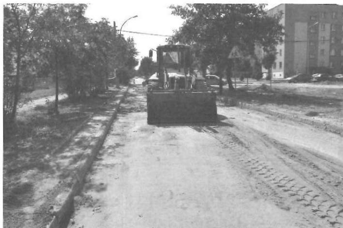
Prace przy przebudowie kanalizacji na ul. Jana Pawła II.
