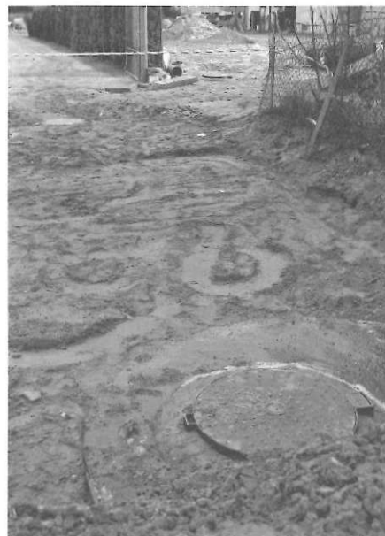
Przebudowany kolektor deszczowy na odcinku od ul. Kilińskiego do ul. Zielonej
