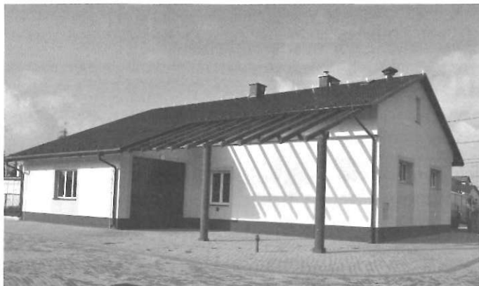
Budynek remizy OSP w Widelce po modernizacji
